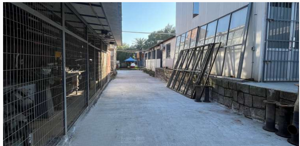
NUEVO RADIER EN MECÁNICA NORTE
